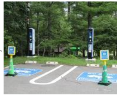
電気自動車用充電スタンド 《ホテル客用駐車場》 ・H26年11月設置
