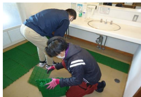
〈スタッフによる小破修繕〉
