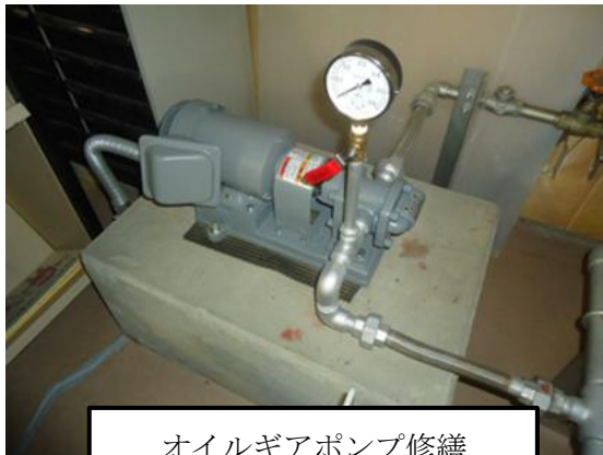
オイルギアポンプ修繕
