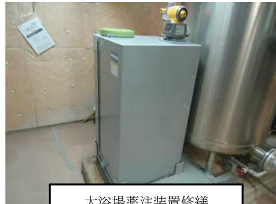
大浴場薬注装置修繕
