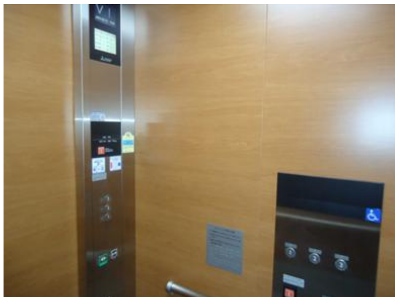
【エレベーター設備更新】
